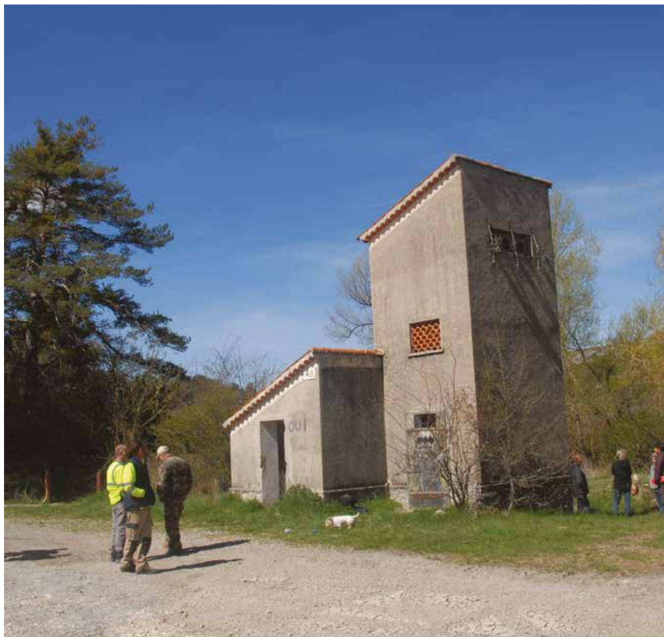
Transformateur aménagé en gîte à chiroptères, Camp militaire de Canjuers (83)
