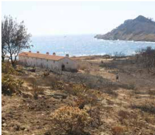
Seule la Maison des Douanes a été épargnée lors de l'incendie de juillet 2017 au Cap Taillat (83)
