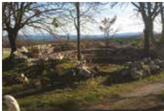
Restauration de murs en pierres sèches, Les Hautes-Plaines de Mane (04)
