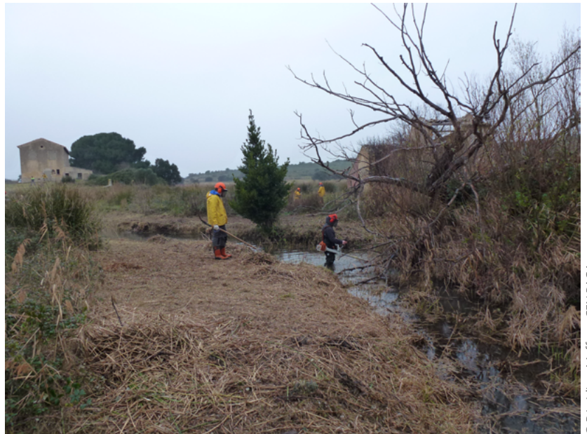
Chantier-école sur la Petite Camargue à Saint-Chamas (13)
