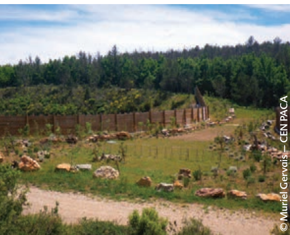
Éco-pont de Brignoles (83)
