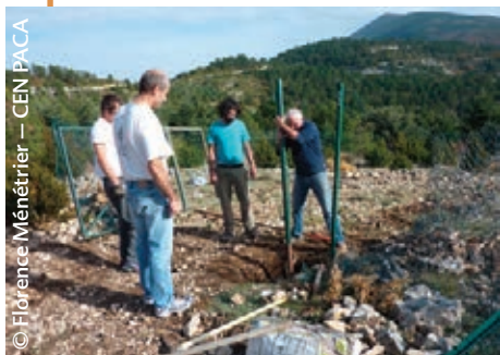
Travaux de restauration d'une placette d'alimentation pour le Vautour percnoptère, Mont Ventoux (84)
