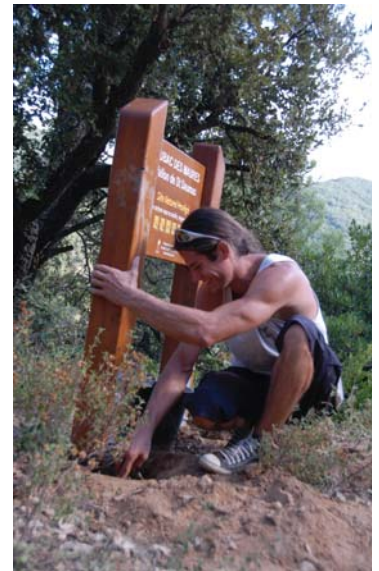
Pose des panneaux d'entrée.
