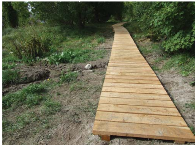
Pose d'un passage sur caillebotis sur des zones de sources pétrifiantes de Saint-Maurin afin de limiter le piétinement
