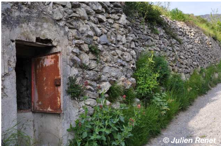
Figure 14 : Regard/conduite d'eau - Saorge, Alpes-Maritimes. © Julien Renet
