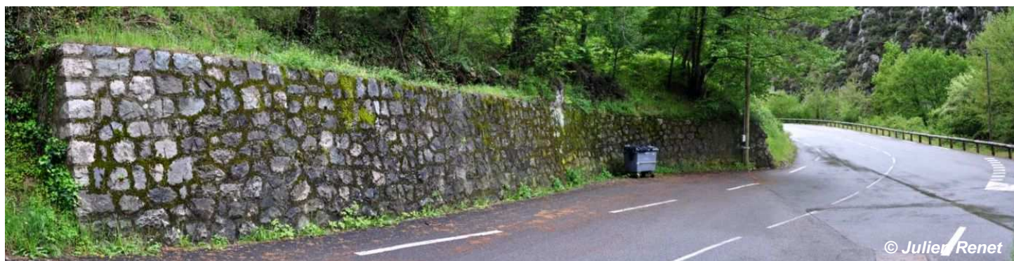
Figure 19 : Mur en pierre de soutènement/bord de route – Saorge, Alpes-Maritimes. © Julien Renet
