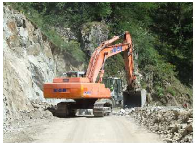
Figure 26 : élargissement d'une piste forestière en montagne
